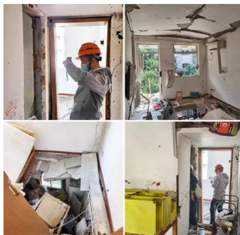
房屋安全检查现场工作
