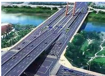
G60 高速公路第三方检测
