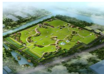
上海虹桥污水处理厂
