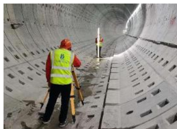
上海 15 号线在建轨交工后监测
