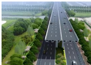
上海两港大道污水主干管项目
