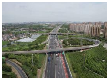
G15 沈海高速道路技术状况评定
