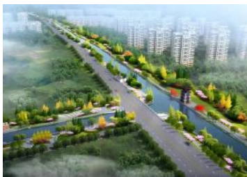
上海杨树浦港－虬江水系地下箱涵结构检测与评估
