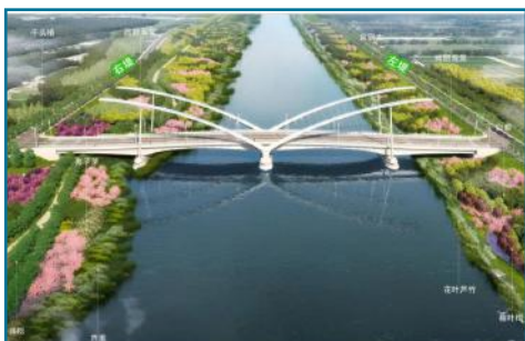
河北省白沟引河留通桥工程
